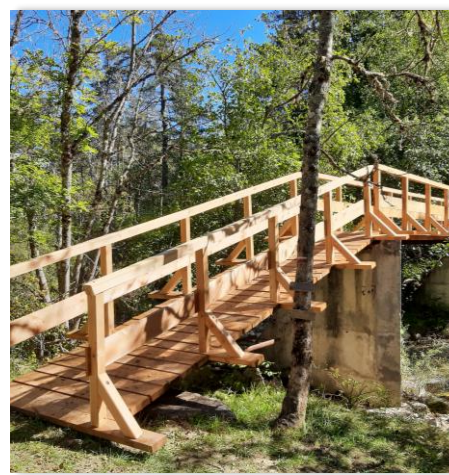
Rampe d'accès reconstruite
