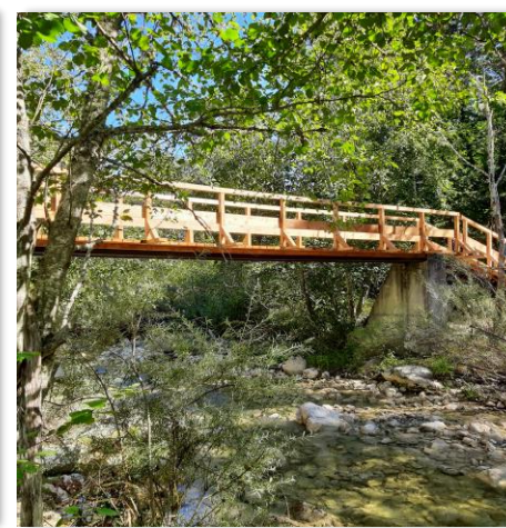
Garde-corps bois remplacés
